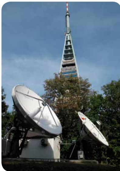
Uplinková stanice společnosti Towercom v Bratislavě © Towercom
